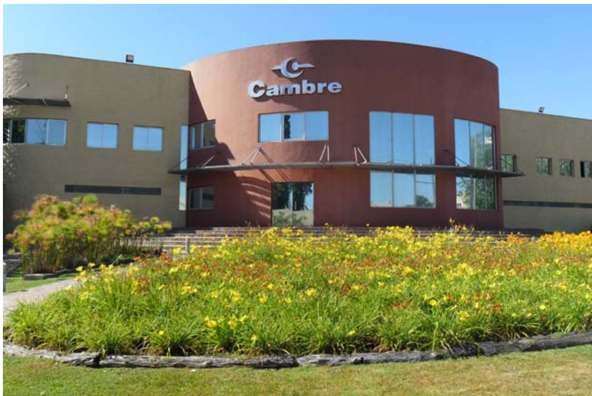
PLANTA INDUSTRIAL CAMBRE. Parque Industrial Garín, Escobar, Provincia de Buenos Aires, Argentina.
